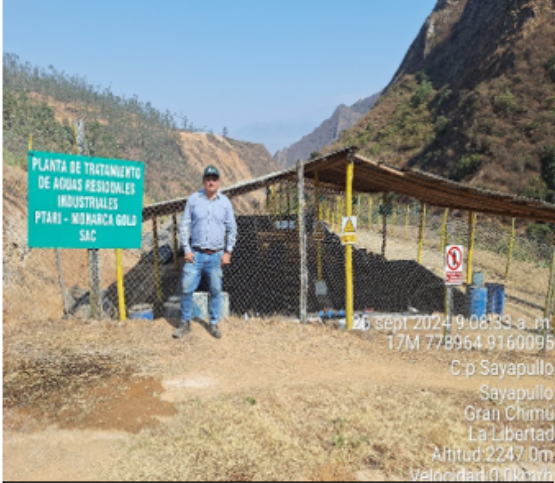
Fotografía 4. Se aprecia la PTARI construida por MONARCA GOLD S.A.C.
