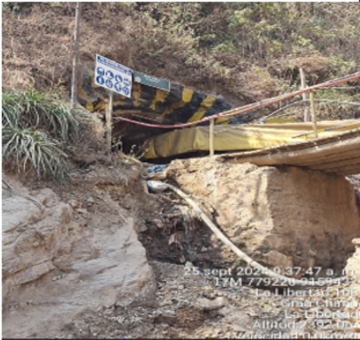
Fotografía 3. Bocamina Esperanza se aprecia que mejoramiento en el conducto de ventilación
