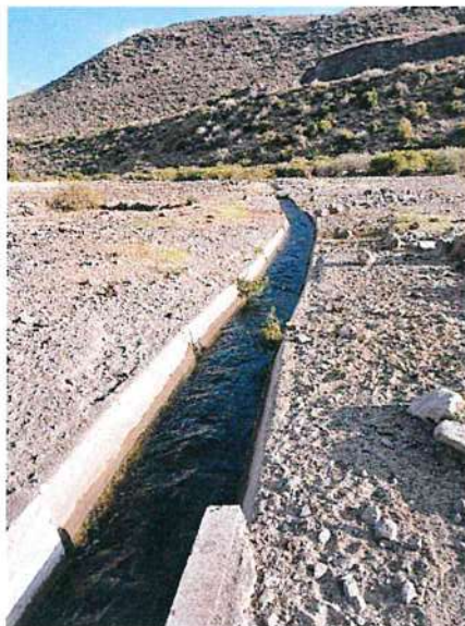
CANAL DERIVACION: CASTROPAMPA
