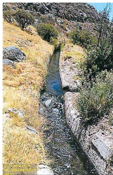
C.D. CARHUASI - ESCALERA
