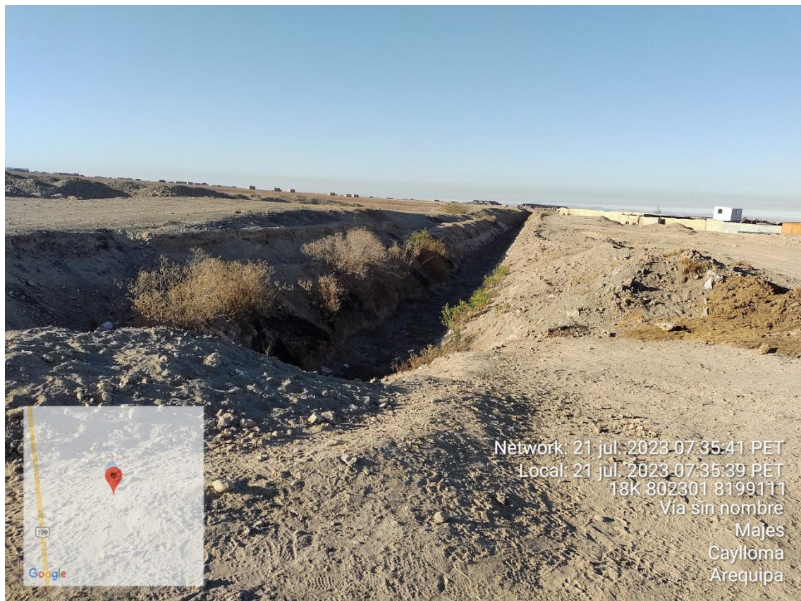
Imagen Nro. 01.- Instalación de viviendas informales en la margen derecha del canal de limpieza del vaso regulador VR7 de la Comisión De Usuarios Del Sub Sector Hidraulico 1R-E4
