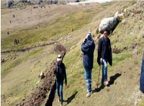
Foto N° 06: Apertura de zanja en forma transversal a la quebrada Pichaccani
