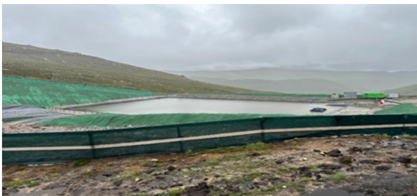
Poza de Sedimentación A, contruida en el cauce de la quebrada Pichaccani
