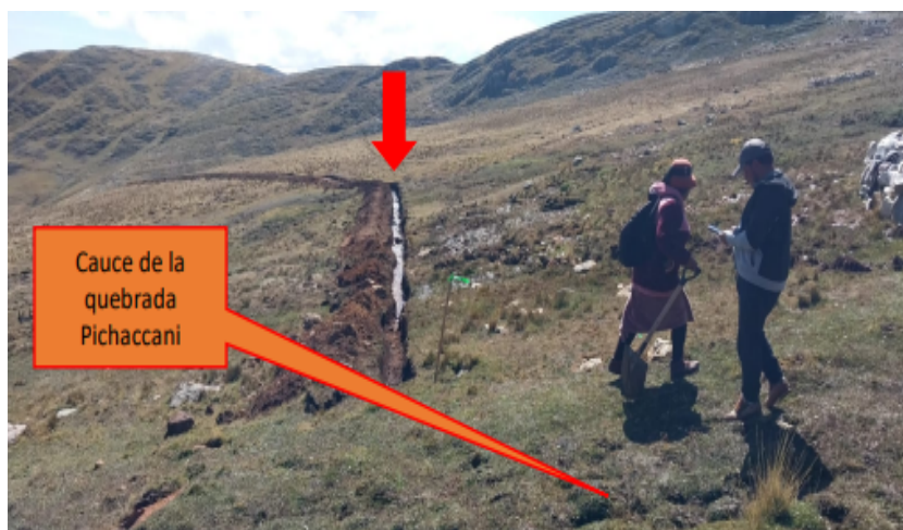
Foto N° 01: Apertura de zanjas transversales en el margen derecho de la quebrada Pichaccani
