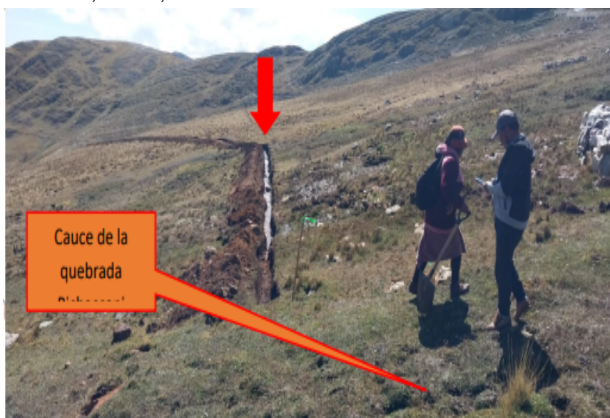
Foto N° 01: Apertura de zanjas transversales en el margen derecho de la quebrada Pichaccani
