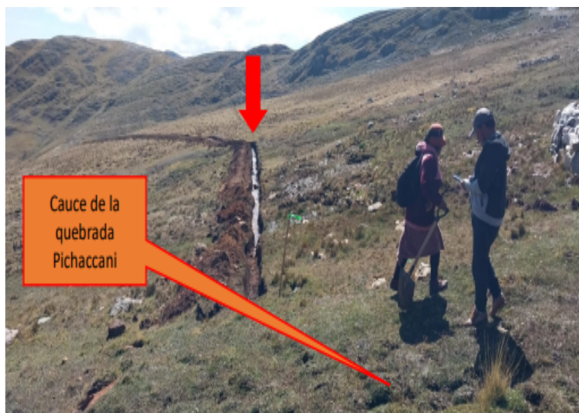
Foto N° 01: Apertura de zanjas transversales en el margen derecho de la quebrada Pichaccani
