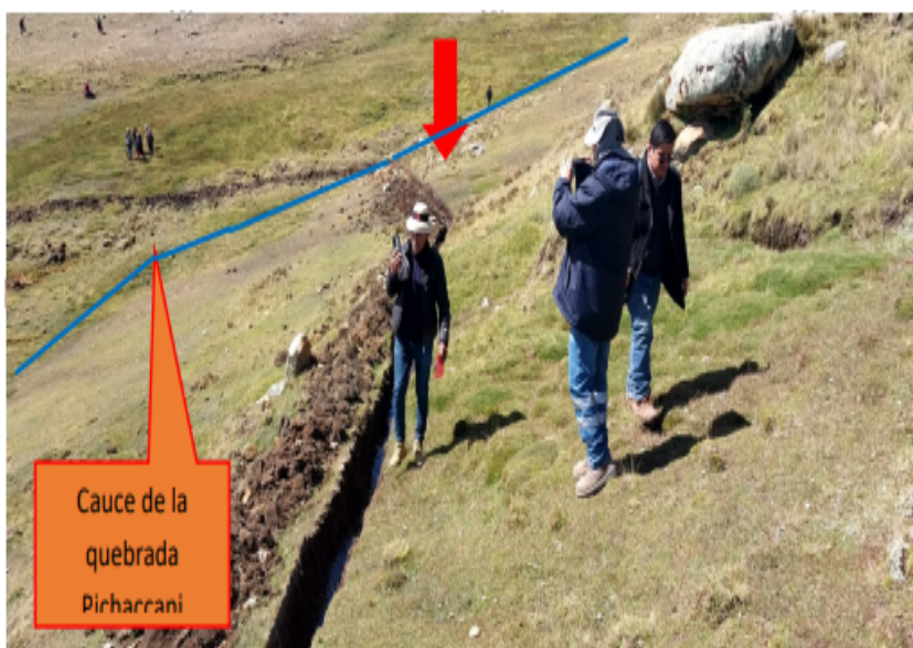
Foto N° 02: Apertura de zanjas de forma transversal en la quebrada Pichaccani.
