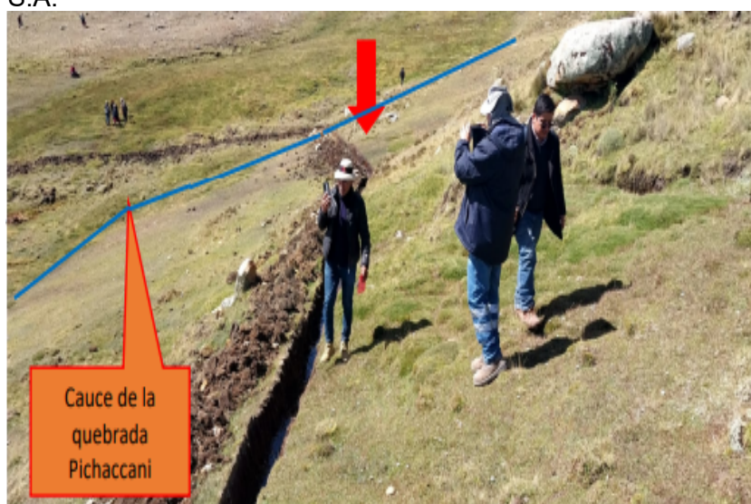
Foto N° 02: Apertura de zanjas de forma transversal en la quebrada Pichaccani.
