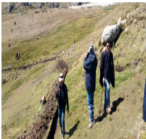
Foto N° 06: Apertura de zanja en forma transversal a la quebrada Pichaccani.
