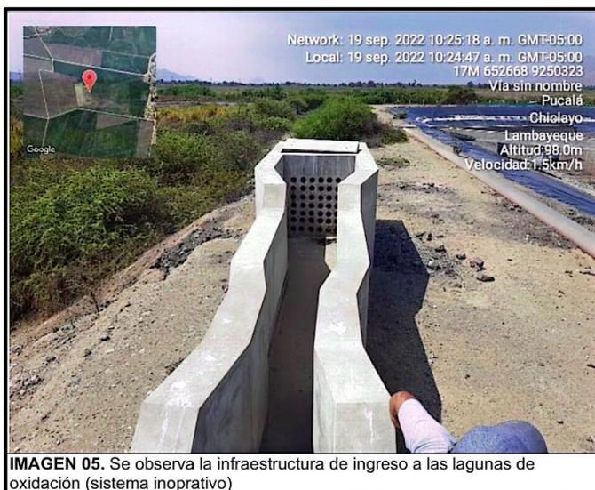
**IMAGEN 05.** Se observa la infraestructura de ingreso a las lagunas de oxidación (sistema inoprativo)
