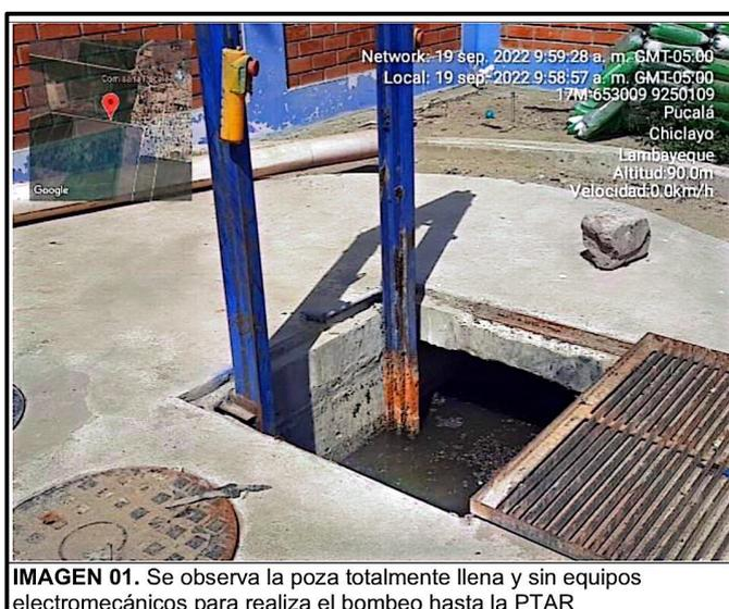
**IMAGEN 01.** Se observa la poza totalmente llena y sin equipos electromecánicos para realiza el bombeo hasta la PTAR
