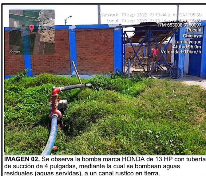
**IMAGEN 02.** Se observa la bomba marca HONDA de 13 HP con tubería de succión de 4 pulgadas, mediante la cual se bombean aguas residuales (aguas servidas), a un canal rustico en tierra.
