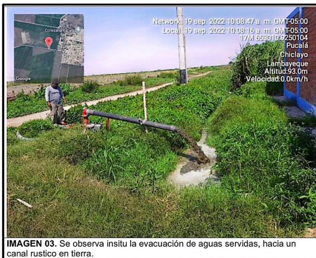
**IMAGEN 03.** Se observa insitu la evacuación de aguas servidas, hacia un canal rustico en tierra.
