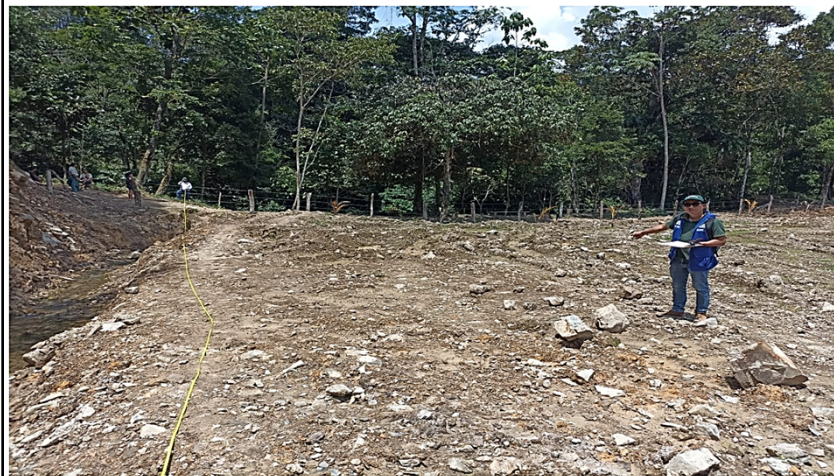
fotografía N° 03: Daño a la faja marginal producto de nivelación con maquinaria.
