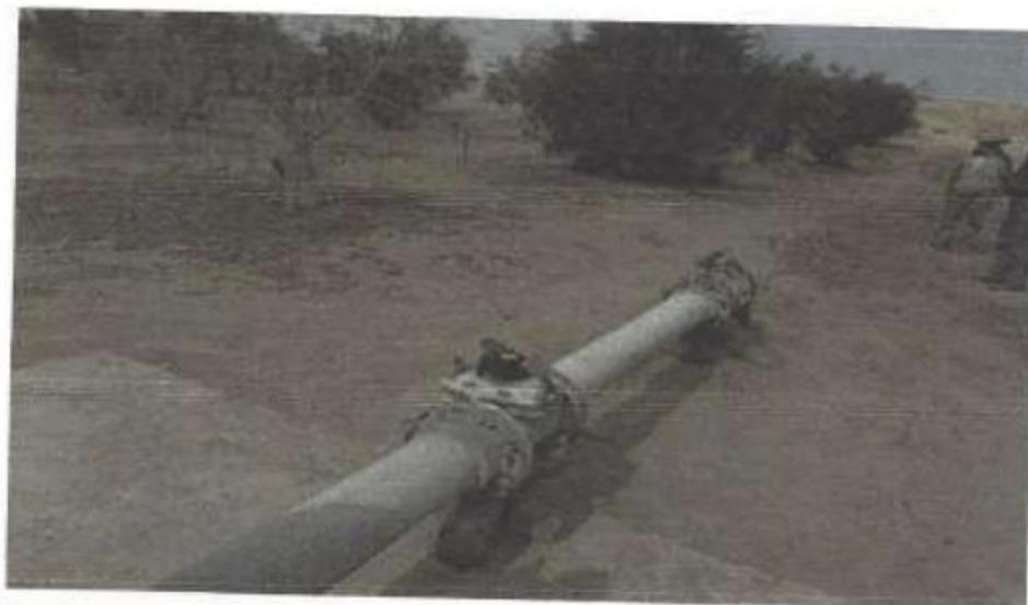
Foto N° 03 El pozo IRHS 11-01-08-1295, se encuentra instalado la tubería de descarga y el dispositivo de medición – Caudalímetro.
